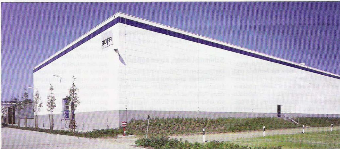
Abb. 1: Beim Neubau der Lagerhalle der Baysystems BÜFA Polyurethan GmbH & Co. KG in Oldenburg standen Funktionalität und Wirtschaftlichkeit im Vordergrund. Das Gebäude, eine Stahlbetonkonstruktion mit liegenden Porenbeton-Montagebauteilen, bietet einen hervorragenden Wärme- und Brandschutz
