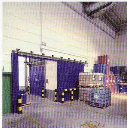
Abb. 4: Eine Komplextrennwand aus Porenbeton sorgt für die nötige brandschutztechnische Trennung des Lagers vom Bereitstellungsbereich für den Versand Fotos: Bundesverband Porenbeton
