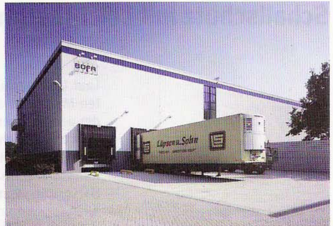
Abb. 3: Mit dem Neubau stimmt jetzt auch der Verkehrsfluss: Anlieferung und Versand – früher kombiniert – sind getrennt, was die Sicherheit auf dem Firmengelände weiter erhöht
