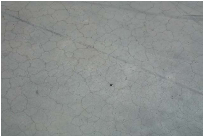
- Typische Industriefußbodenoberfläche mit Krakelierungsrisssbild
