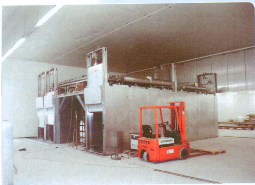
Die Arbeiten an der neuen, automatisierten Durchlauf-Selchlaufen auf Hochtouren.
